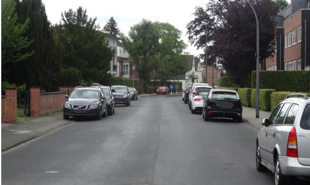
*Bild 7: Strundener Straße im Bereich mit 8,5 m Fahrbahnbreite: Hier ist eine 4,5 m breite Fahrgasse einschließlich seitlichen Markierungen möglich*
